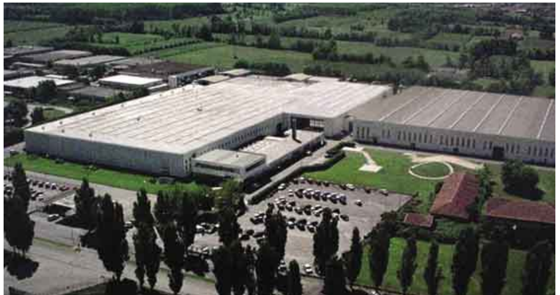
Fig. 1 - Il grande stabilimento della GGP Italy, dove è installato un nuovo impianto di verniciatura che utilizza nanotecnologie di pretrattamento, finiture a polveri e trattamento delle acque di processo a “scarico liquido zero”.
