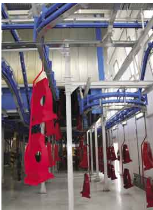
Fig. 19 - A sinistra di figura i pezzi sono portati al forno di polimerizzazione delle polveri. A destra i pezzi dopo cottura sono trasportati verso la zona di scarico.
