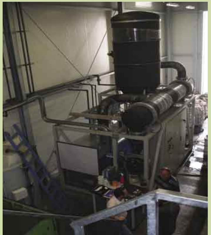
Fig. 27 - A destra, l'evaporatore a ricompressione meccanica dei vapori d'acqua.
